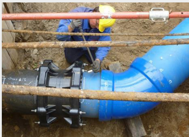
Bild 3: Einbindung DN 500 mit Richtungswechsel
