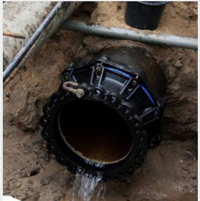
Bild 5: FRIAGRIP®-Flanschadapter DN 500 auf dem alten Rohrende
