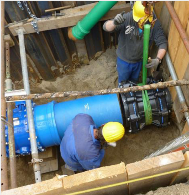
Bild 4: Überschieben der FRIAGRIP®-Kupplung über den Montagespalt
