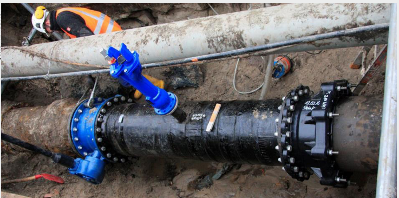
Bild 6: Fertige Einbindung des Schiebers DN 500
