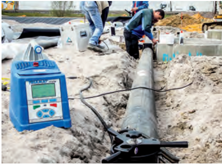
Präzise Montage und einfaches Schweißen eines FRIAFIT-Abwassersattels ASA-TL
