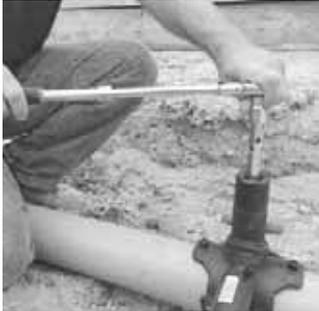
**FWSR****Betätigungsschlüssel für Druckenbohrarmaturen mit parallelem Dom (DAP)**
